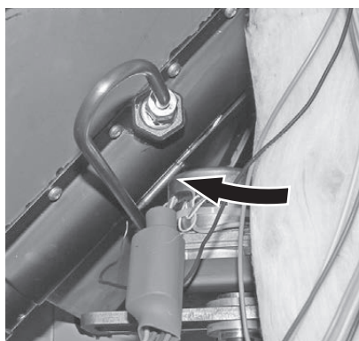
rys. 44 Wsunąć do oporu czujnik termostatu bezpieczeństwa rury ślimaka
