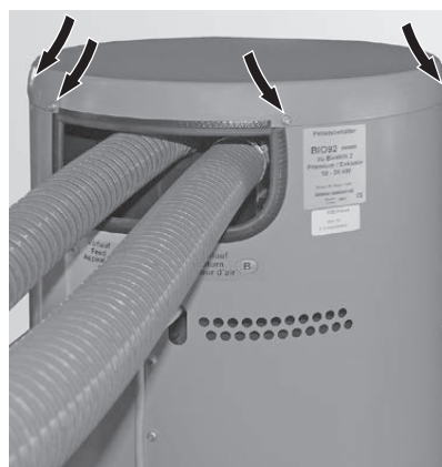
rys. 82 Zamontować węży powietrza
