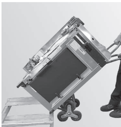
rys. 15 Zdjąć kocioł z palety za pomocą dwukołowego wózka taczkowego
