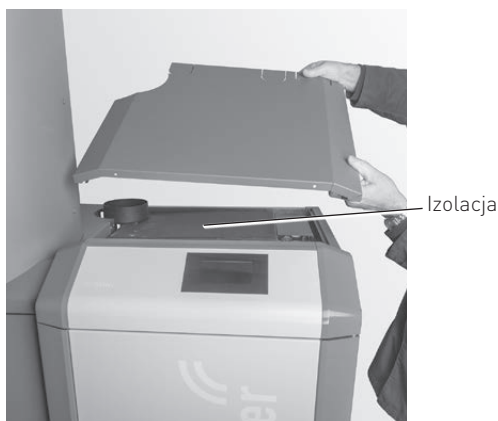
rys. 109 Zdjąć pokrywę obudowy, wyjąć izolację
