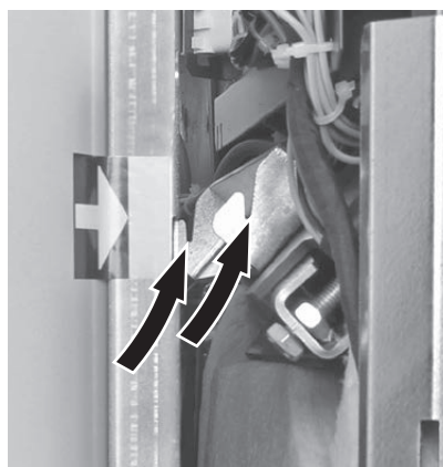
rys. 39 Zawiesić zasobnik pelletu dla kotła na dwóch zaznaczonych hakach
