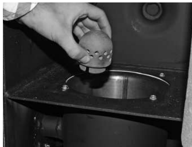
rys. 79 Wyjmij wkład kulisty palnika
