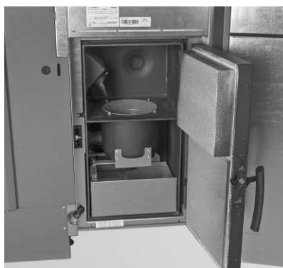
rys. 66 Otwórz drzwiczki zewnętrzne oraz drzwiczki komory spalania
