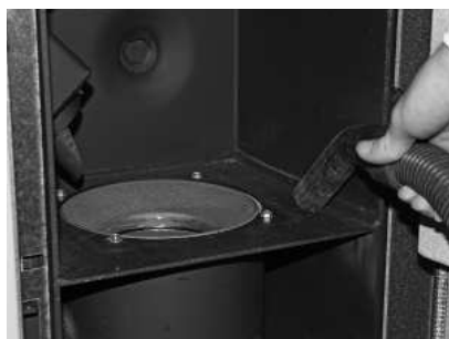
rys. 73 Usunąć resztki popiołu i zanieczyszczeń
