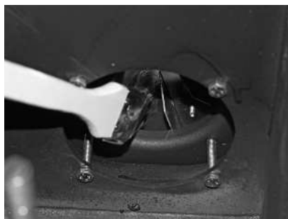
rys. 90 Wyczyścić i odkurz śmigło wentylatora
