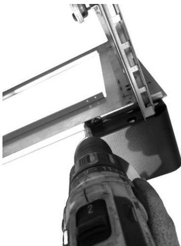
Rys. 41 - Montaż stóp 1
