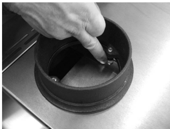
Rys. 51 - Mocowanie gniazda
